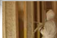
*ウレタン吹付けによる 高気密・高断熱のお家
